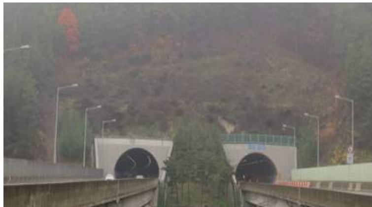
(시점부 절토사면 전경)
